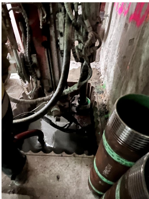
Figur 9: Ursparing genom källargolvet där pålarna borras. Det yttre röret på bilden är det som sedan bildar pålen, inre röret på bilden roterar och förser hammaren med vatten för drivning, när installationen är klar plockas det inre röret upp ur röret. Fotografi taget av Amanda Koch
