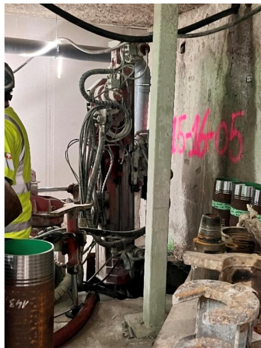
Figur 8: RD – borrning med Vattenhammare i källaren på skattehuset. Fotografi taget av Amanda Koch
