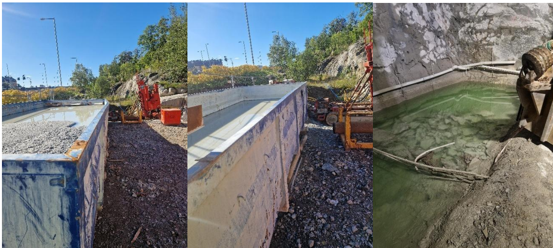
Figur 7: Fotografier tagna av Shahab Salehi. Bilder från vänster; Bild 1: sedimenteringscontainer 1 med borrhslam, Bild 2: sedimenteringscontainer 2 med vatten för recirkulering, Bild 3: vatten som kom ner i tunneln efter genomslag av pilothål.
