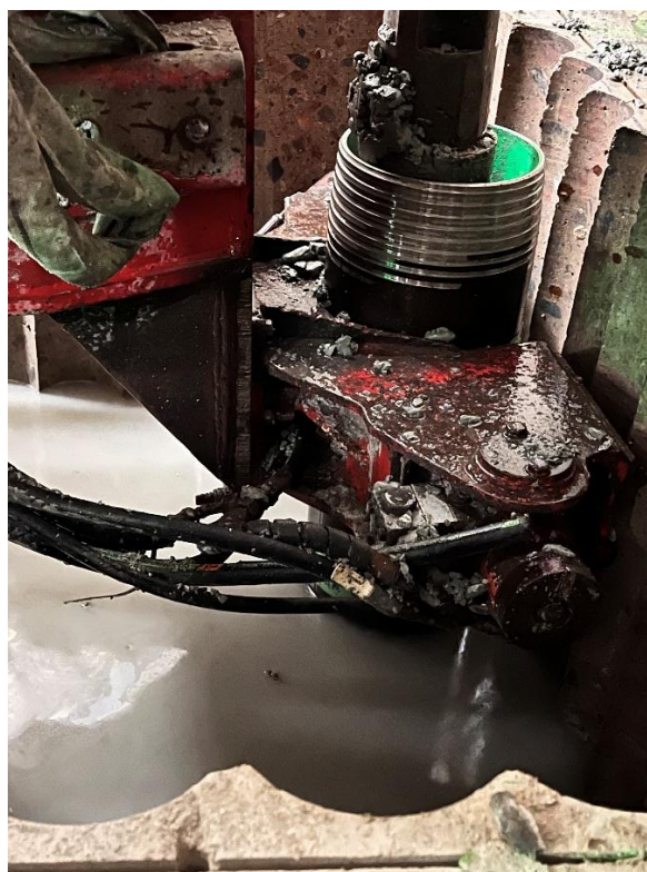
Figur 9: Ursparing genom källargolvet där pålarna borras. Det yttre röret på bilden är det som sedan bildar pålen, inre röret på bilden roterar och förser hammaren med vatten för drivning, när installationen är klar plockas det inre röret upp ur röret. Fotografi taget av Amanda Koch
